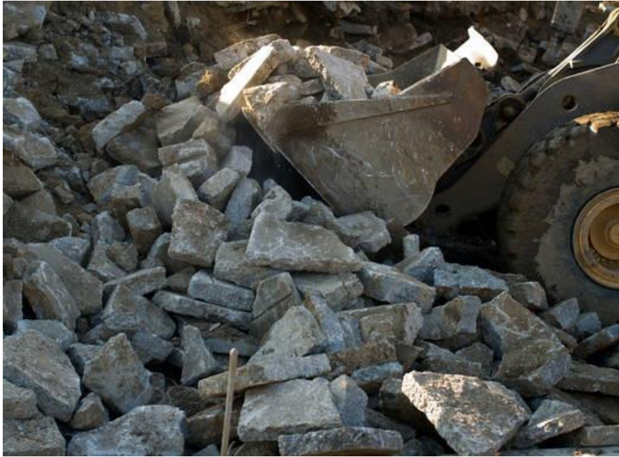
Slika 4-7. Utovar betonske šute bagerom sa vodonepropusnog platoa
