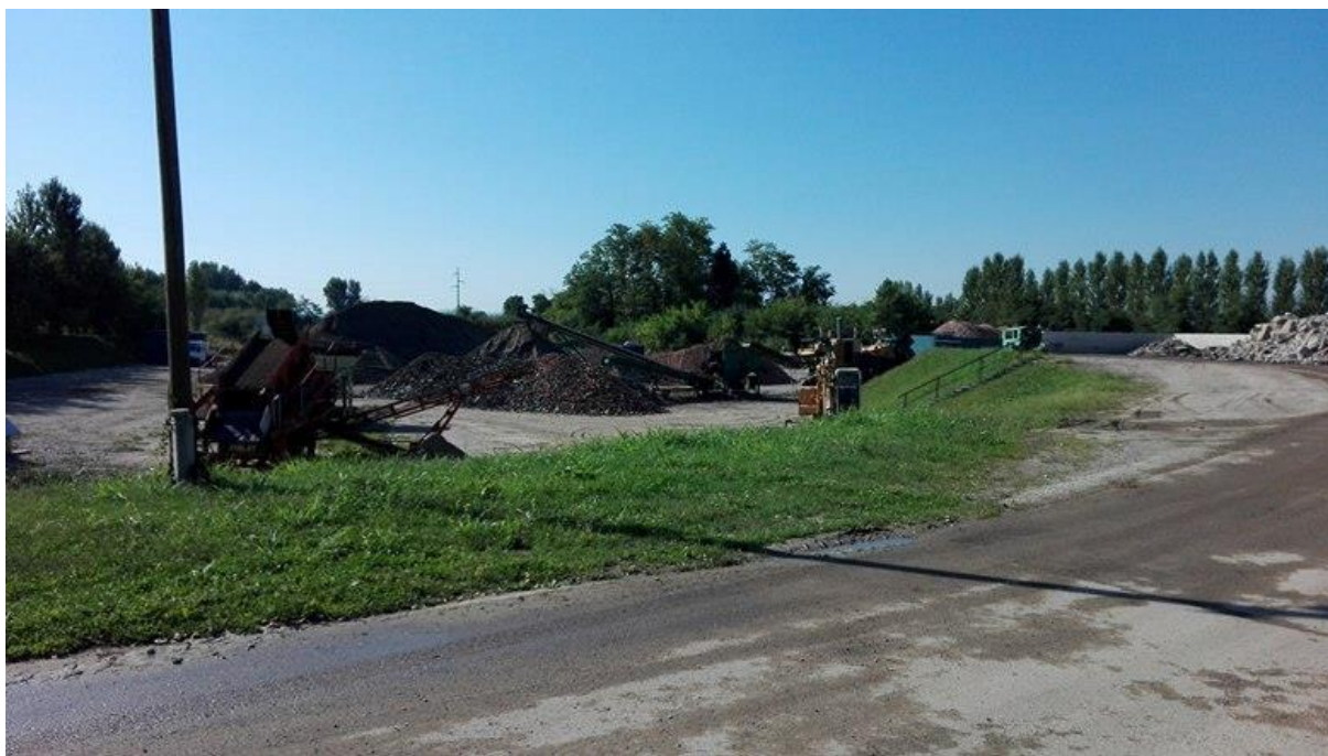
Slika 4-1. Teren i postrojenje reciklažnog dvorišta „Mišić“
