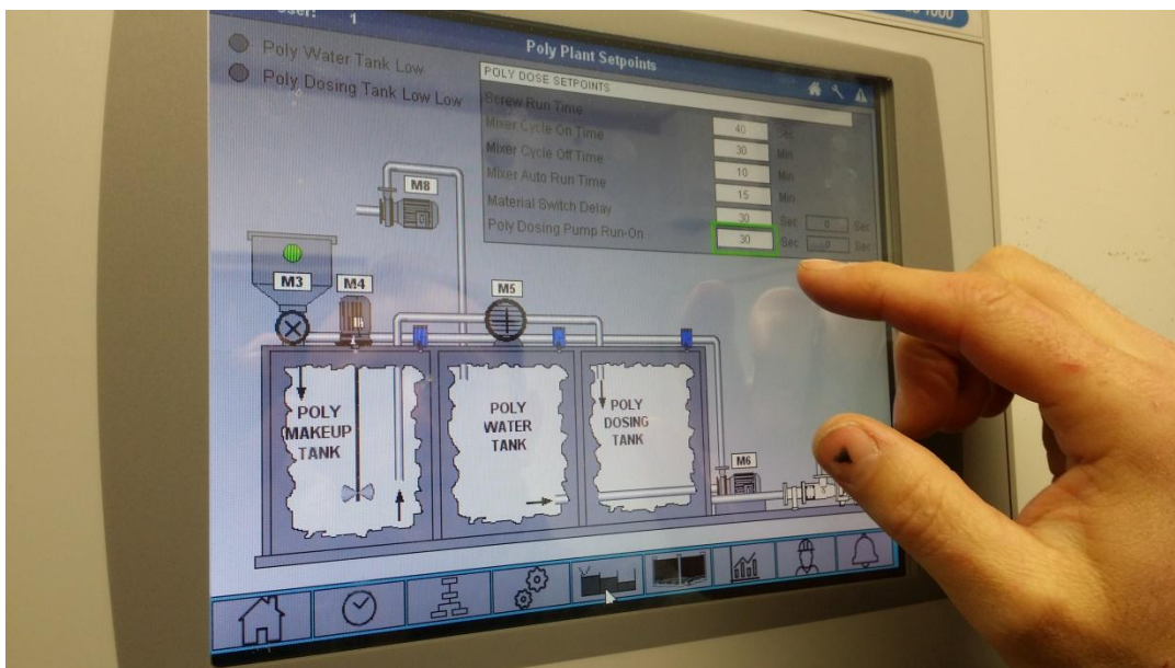
Slika 3-8. Zaslون upravljačke jedinice stanice za pripremu flokulanta
