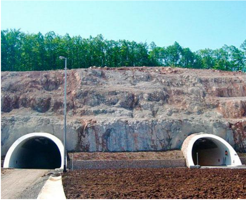
Slika 2-1. Tunel „Brezik“ (Viadukt d.d., 2003)
