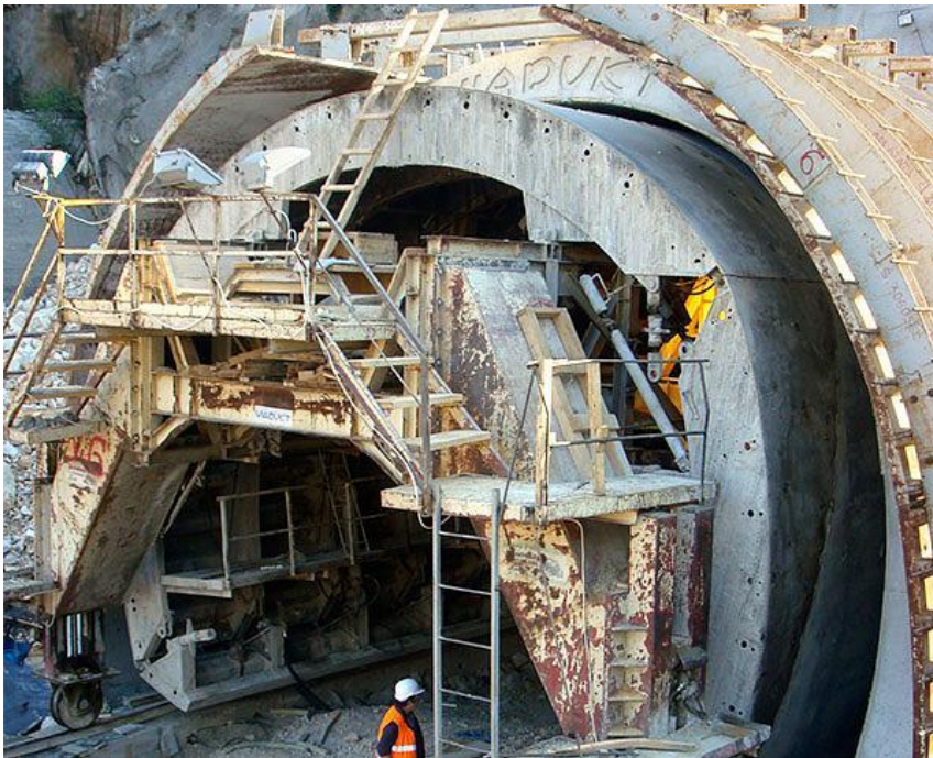
Slika 2-4. Tunel „Škurinje II“ (Viadukt d.d., 2008)
