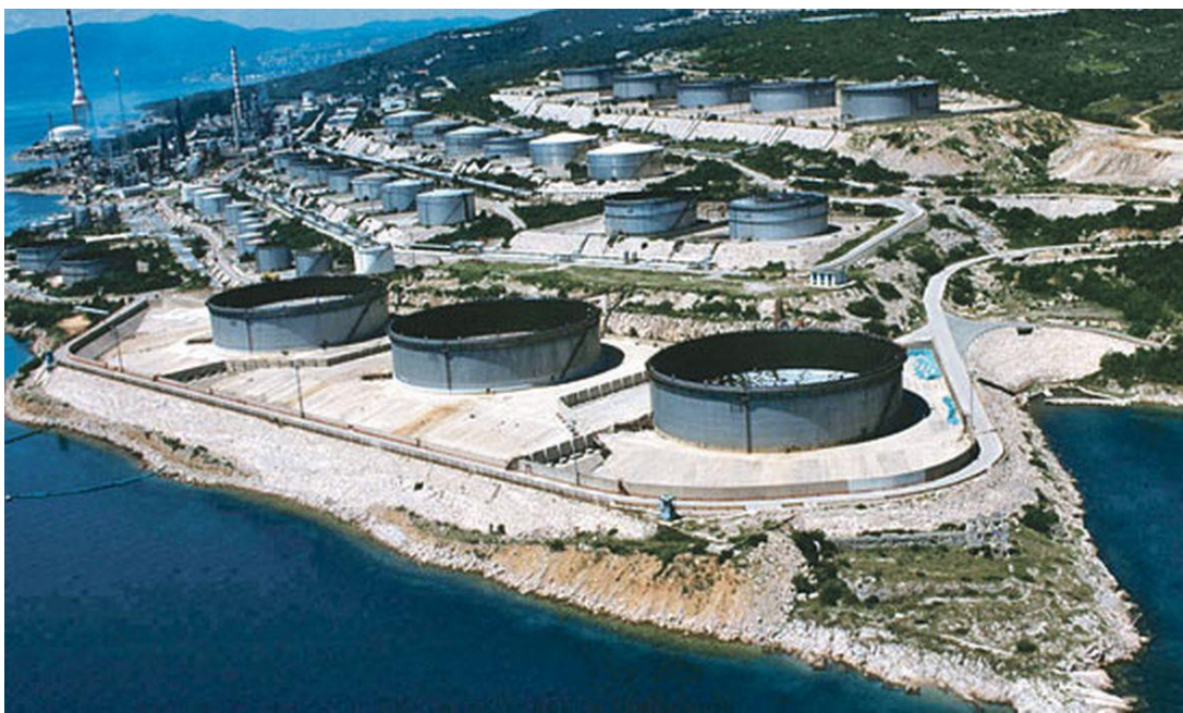
Slika 4-1. Rafinerija nafte Rijeka (Pleše, 2013)
