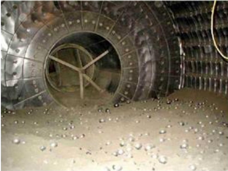
Slika 4-2. Unutrašnjost mlina s kuglama za mljevenje klinkera (Ćurković 2015).
