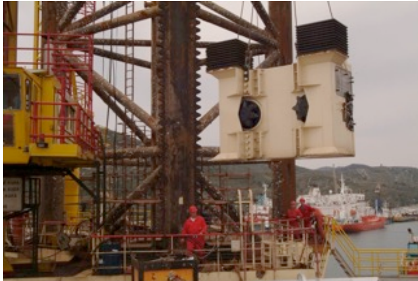
Slika 4-3. Podizanje dodatnog podiznog sustava (Sabljak, 2005)
