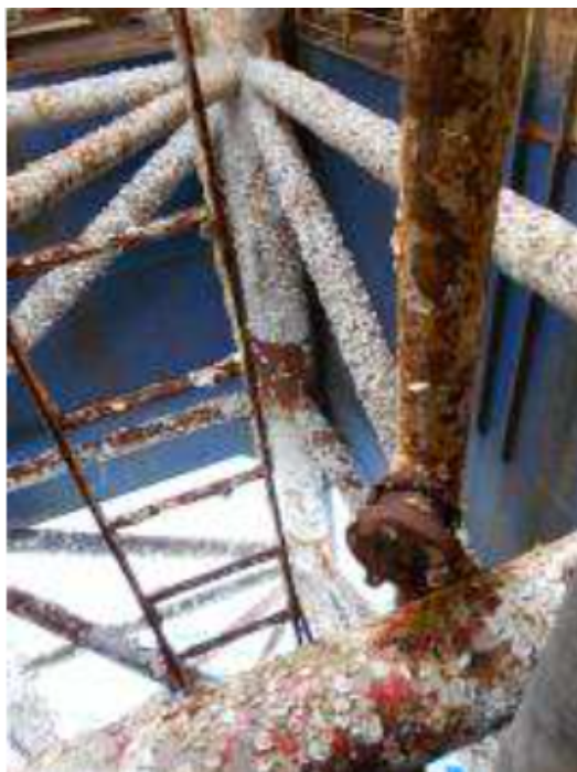
Slika 5-11. Dotrajali mlazni cjevovod (Crosco, 2015c)
