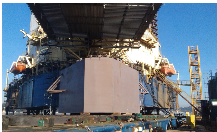
Slika 5-2. Postavljanje pramčane ekstenzije (Crosco, 2015c)
