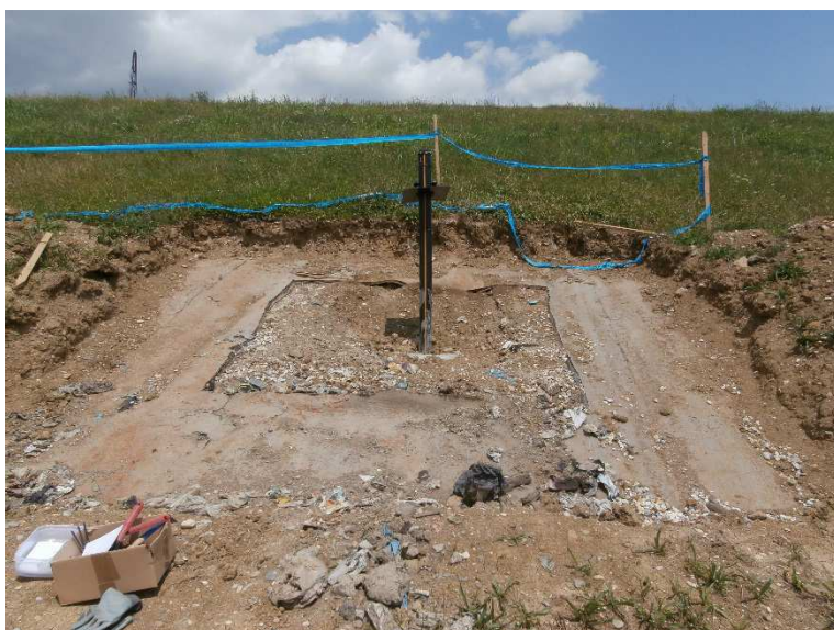
Slika 8-8 Nadsloj iznad istražnog raskopa S7
