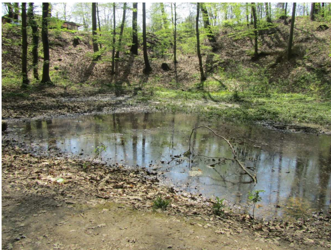
Slika 82 Glavna pukotina i udubljenje ispunjeno vodom u gornjem dijelu pokrenute mase na velikom starom klizištu na Grmošćici (snimljeno 2013. godine)
