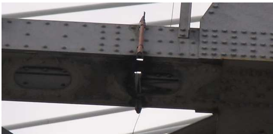
Slika 4-9. Postavljanje linijskih kumulativnih rezača prilikom rušenja mosta
