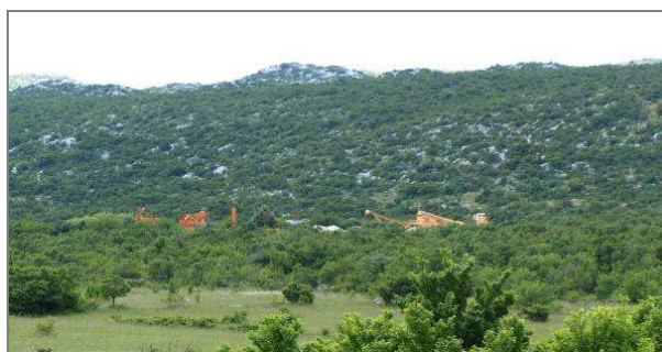
Slika 8.7. Asfaltna baza u Konjskom
