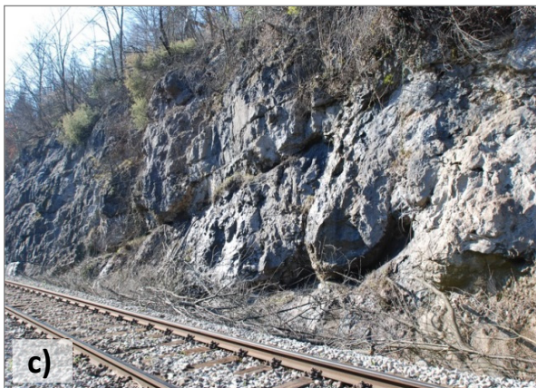
Slika 5-13. Procjena parametra Razvedenost : a) klasa I (604, 95-D); b) klasa II (604, 19-D); c) klasa III (502-19-D); d) klasa IV (202-59-L)
