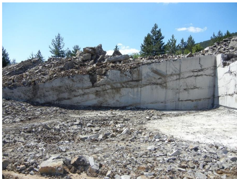
Slika 3-4 Pregled istražnog zasjeka
