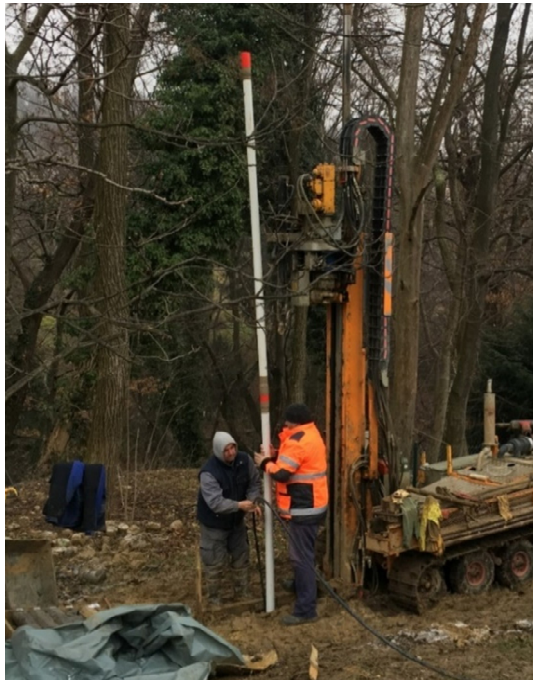
Slika 3.4 Ugradnja inklinometra u bušotinu B-4.
