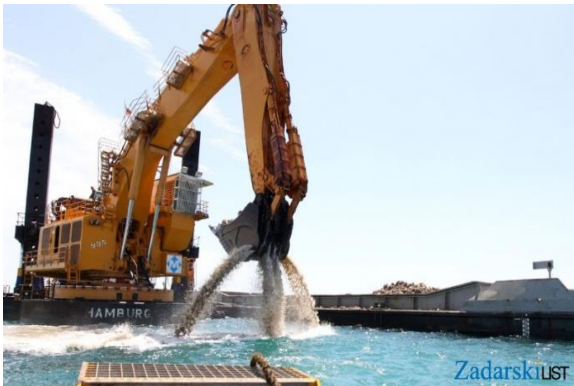
Slika 2-2. – Utovar minirane mase (Zadarski List,2018.)
