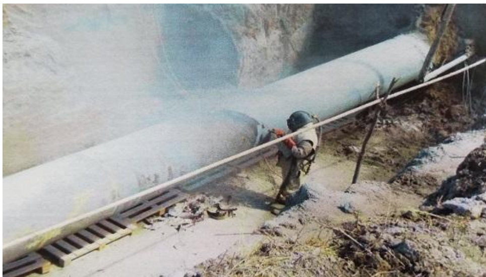
Slika 5-8. Postupak pjeskarenja cijevi (JANAF D.D., 2016)
