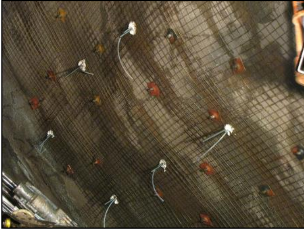
Slika 5-3. Čelična mreža pričvršćema sidrima (TEDESA - Técnicas de Entibación, S.A., 2013.)
