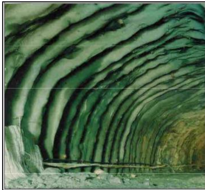
Slika 6-3. Praktična izvedba RRS sistema (Grimstad et. al, 2012.).
