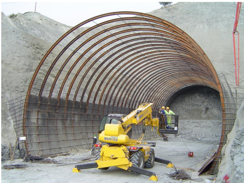
Slika 5-4. Detalj čeličnog luka pri bušenju ulaznog portala tunela (TEDESA - Técnicas de Entibación, S.A., 2013.)
