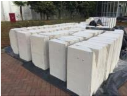
Slika 2-1: betonski blokovi kao građevinski otpad (Dijamantna tehnika Kapusta)
