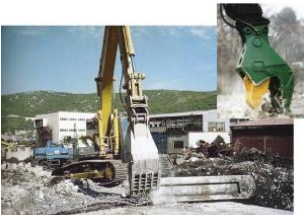
Slika 4-4: Usitnjavanje hidrauličnim škarama (krešerom) (Lovinčić, 2018)
