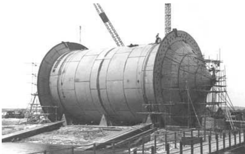
Slika 2-3. Izrada prvog bubnja za namatanje cjevovoda za operaciju PLUTO (Blogs from DNV GL, 2018)
