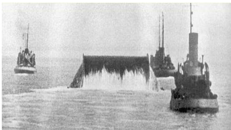
Slika 2-2. Polaganje nizova cjevovoda pomoću brodova (D Day Overlord, 2018)
