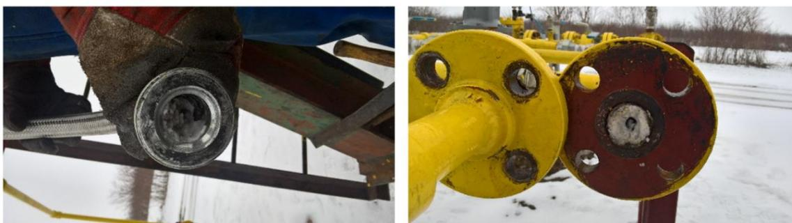
Slika 4-5. Zamrzavanje kondenzata u usisnim i tlačnim instalacijama (INA d.d., 2018a)
