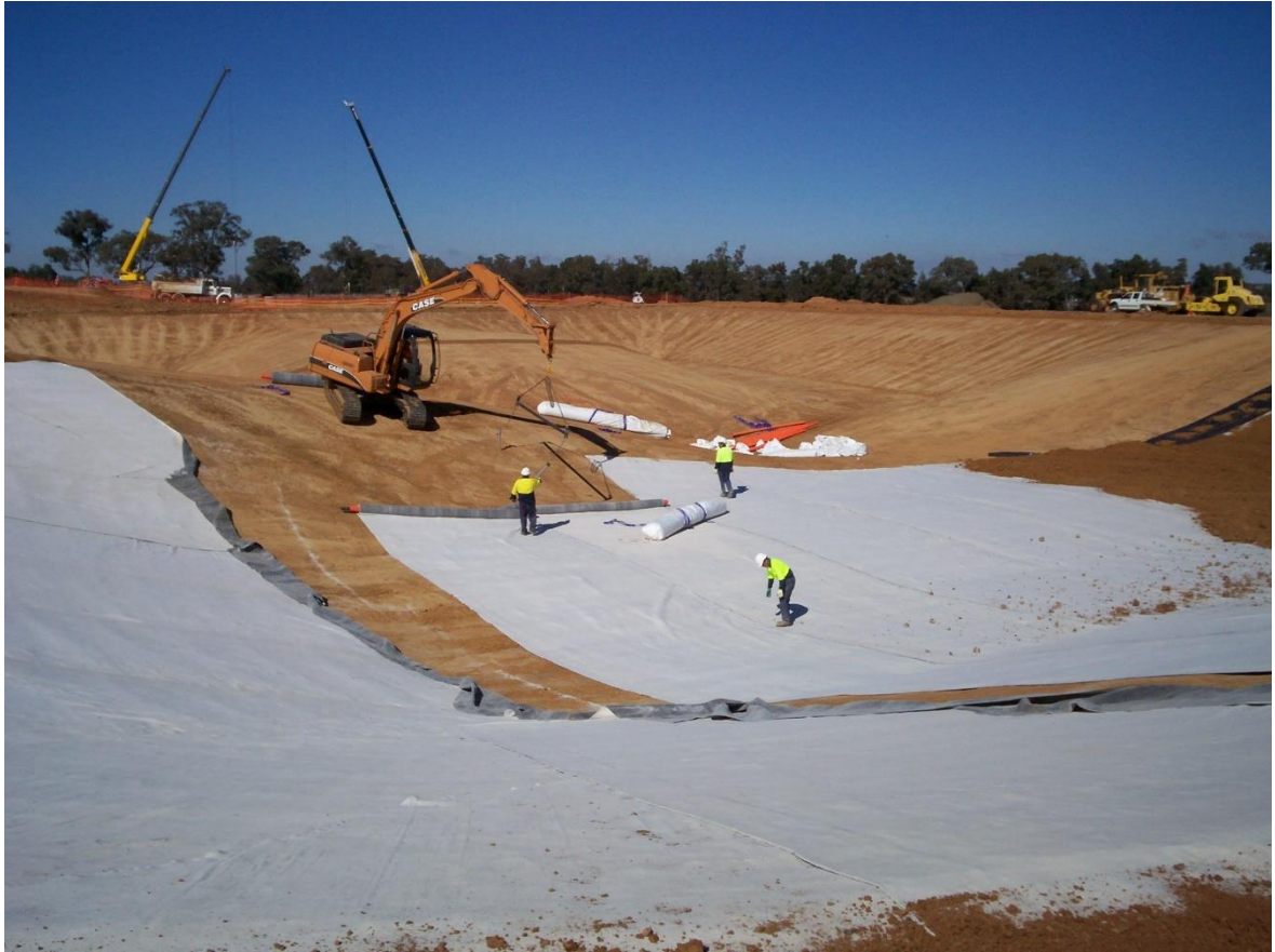
Slika 2-3 Postavljanje geotekstila (Geofabrics, 2017)
