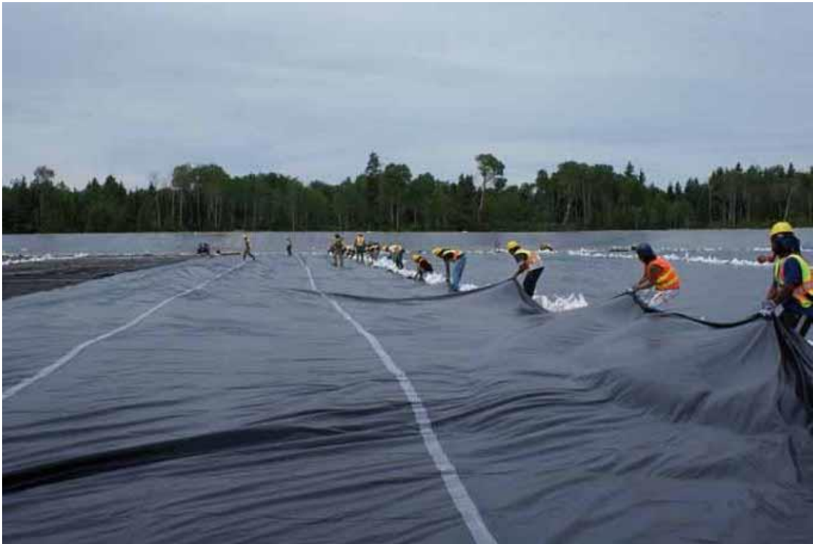
Slika 2-2 Postavljanje geomembrane (Us fabrics, 2018)
