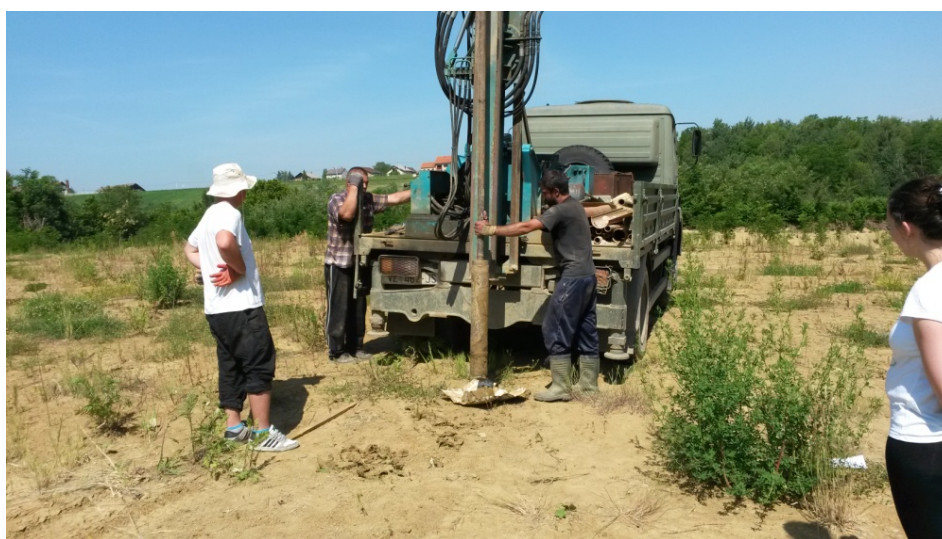
Slika 7.20 Istražna bušenja na eksploatacijskom polju Cukavec II
