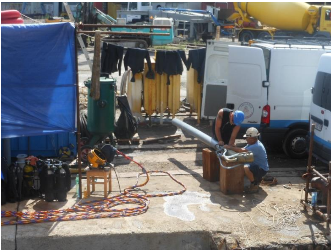
Slika 5-2. Ronilački pregled podvodnih dijelova i servisiranje opreme (Crosco, 2014c)
