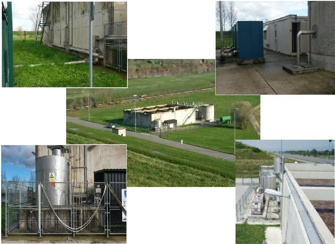
Slika 3-9. Pročišćivač otpadnih voda
