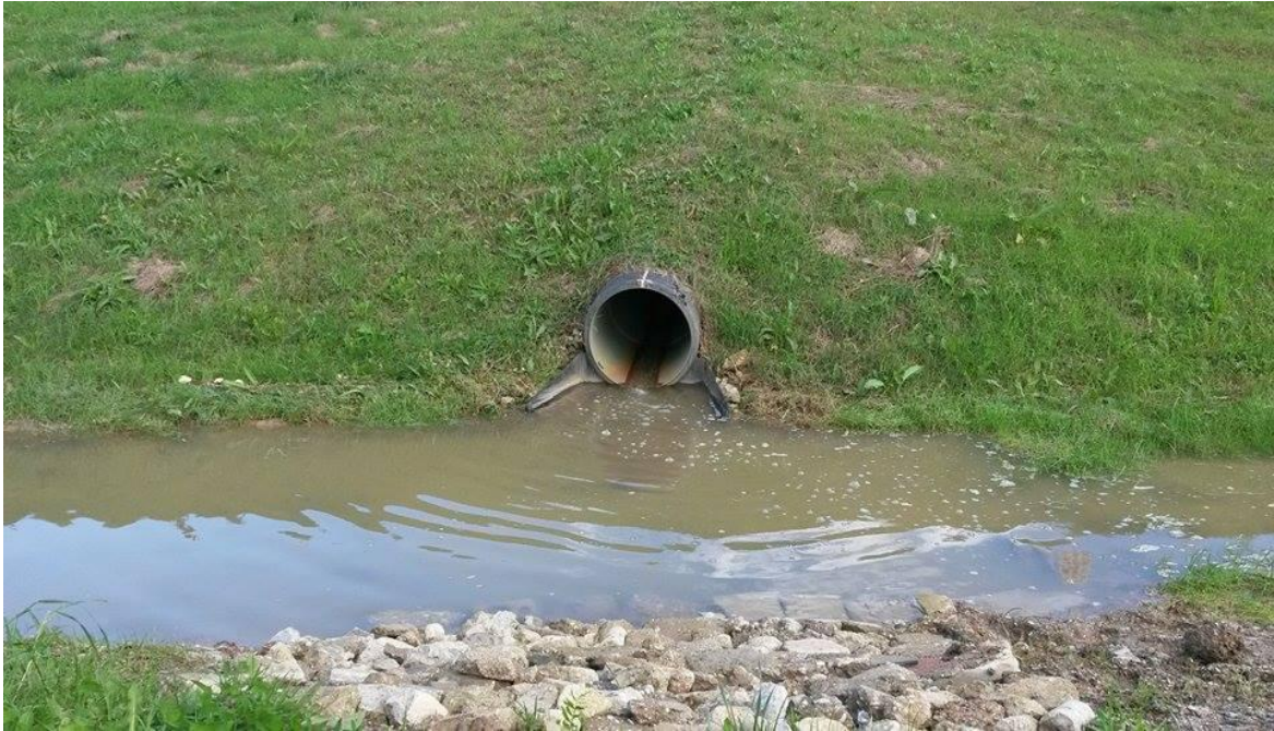
Slika 3-6. Obodni kanal i drenažna cijev
