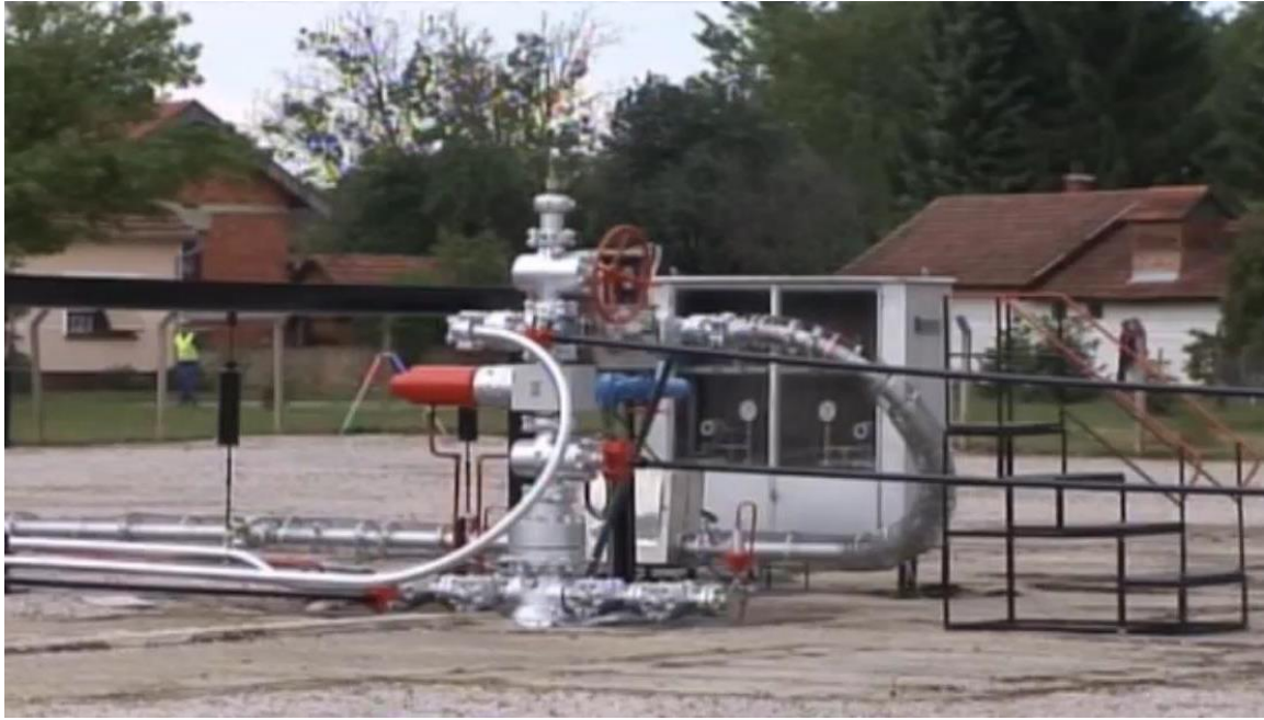
Slika 3-4. Fotografija tipične nadzemne opreme bušotina „Duboke Podravine“ (Tišljar et al., 2015).
