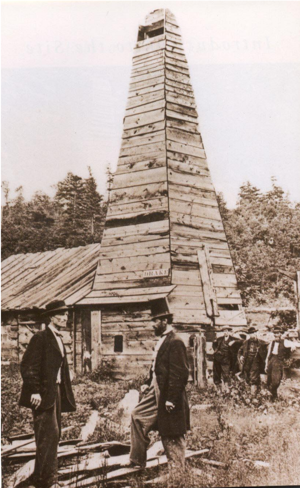
Slika 1-1. Toranj za bušenje Edwina L. Drakea (Britannica, 2015)
