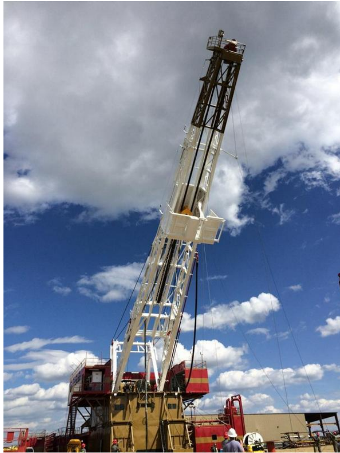
Slika 3-2. Podizanje preklopnog tornja kopnenog bušačeg postrojenja (Citadel, 2014)
