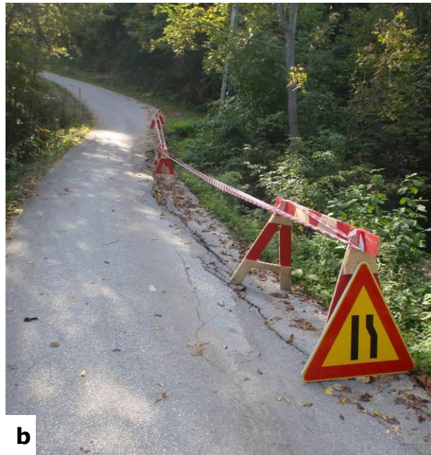
Slika 3.1 Klizište Cerina 1: (a) pogled na čeonu pukotinu klizišta (fotografirano 4.2.2014.); (b) položaj čeonu pukotine klizišta s denivelacijom od 0,2 m (fotografirano 25.9.2014.).
