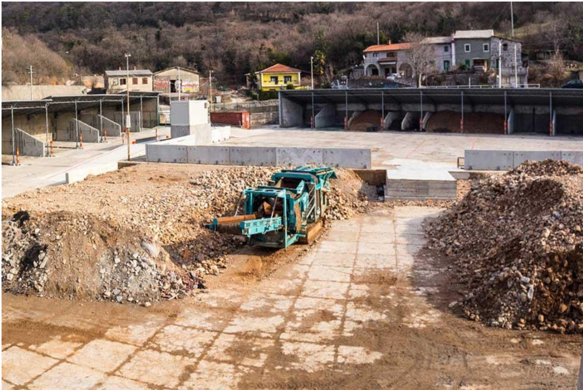
Slika 2-6: Građevni otpad (GRD d.o.o., 2019.)
