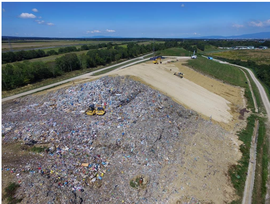
Slika 5.1. Trenutno stanje na odlagalištu neopasnog otpada Mraclinska Dubrava – otvoreni dio odlagališta ( http://www.vgcistoca.hr/odlagaliste-neopasnog-otpada-mraclin/ )
