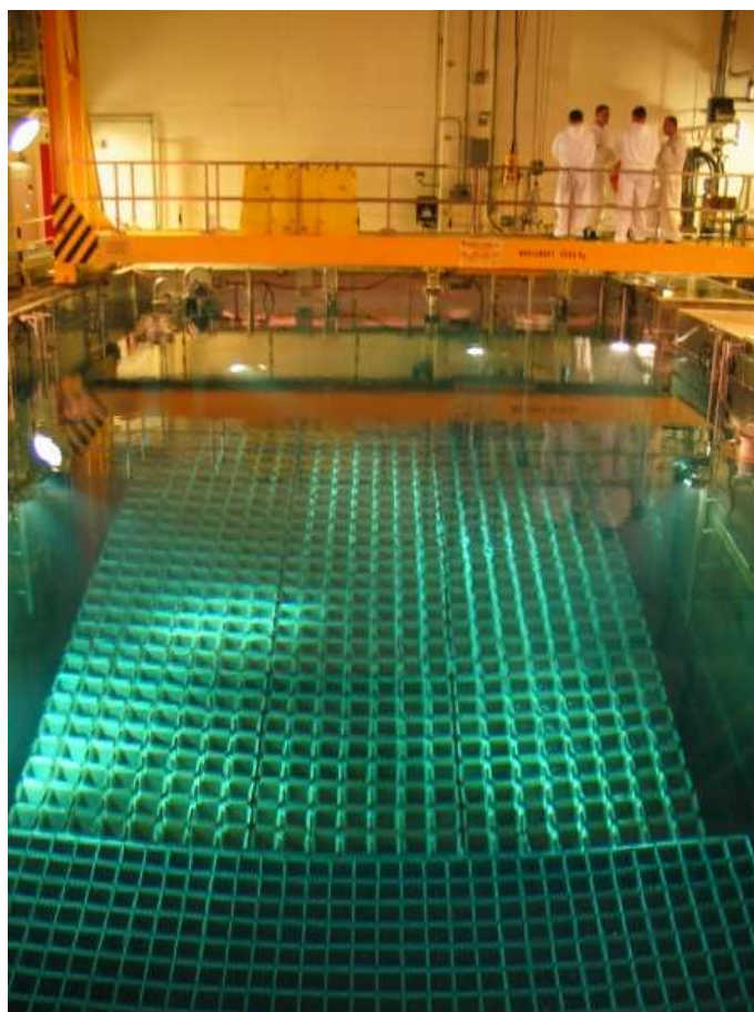
Slika 2-23 Bazen za istrošeno gorivo (ZBRINJAVANJE RAO, 2019)
