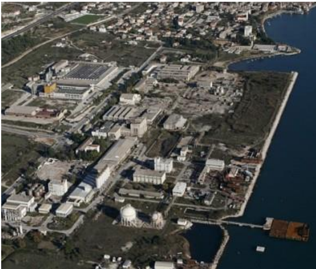
Slika 2.4 Područje bivše tvornice Jugovinil u Kaštel Sućurcu (kastela.org, 2010)
