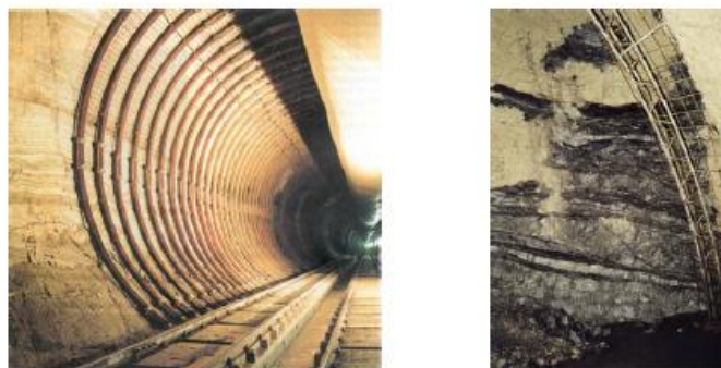
Slika 5-15 Čelični lukovi (Vrkljan,2013.)
