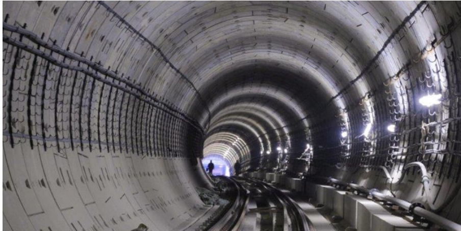
Slika 6-17 Tunel kružnog oblika (Primorac, 2019.)
