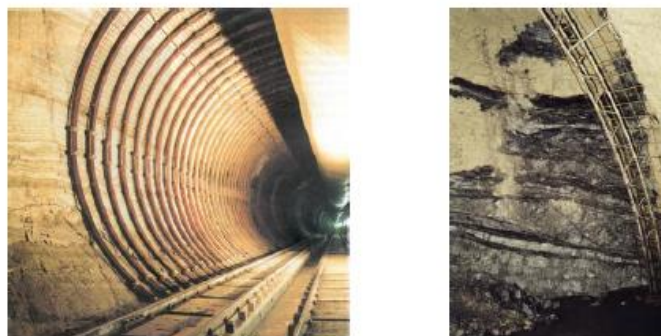
Slika 5-15 Čelični lukovi (Vrkljan,2013.)
