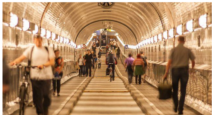
Slika 6-18 Svodasti oblik presjeka tunela (Primorac, 2019.)
