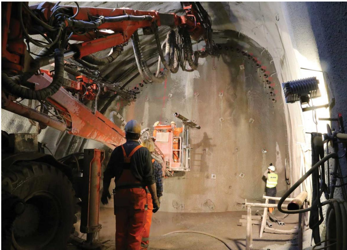
Slika 2-2 Ugradnja cijevi (Tunneling, Rock Support & Geotechnical Solutions by MIPL & ROBIT, 2019)
