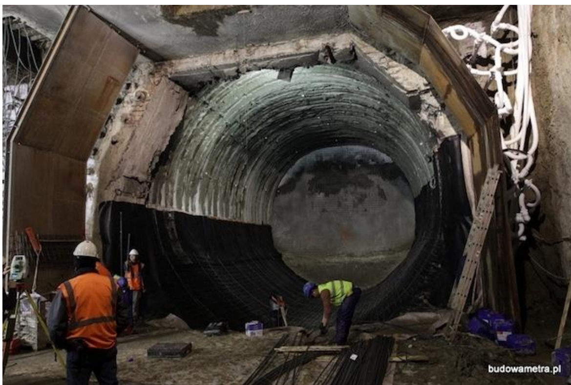
Slika 2-22 Zamrznuto tlo oko čela iskopa tunela (POLONIA - METROPOLITANA VARSAVIA - LINEA II, 2019)
