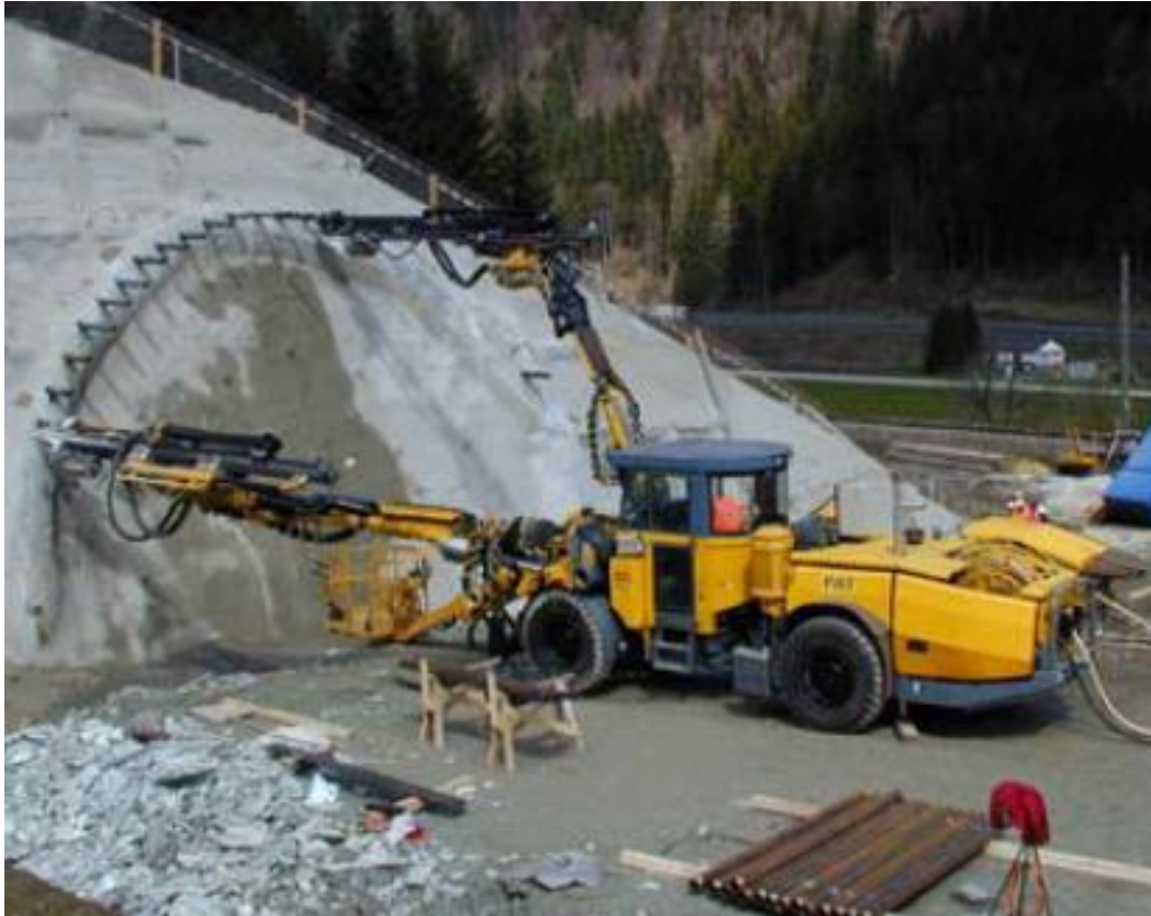
Slika 2-4 Stroj za bušenje kod metode bušenja sa kućištem (Volkman & Schubert, 2008)
