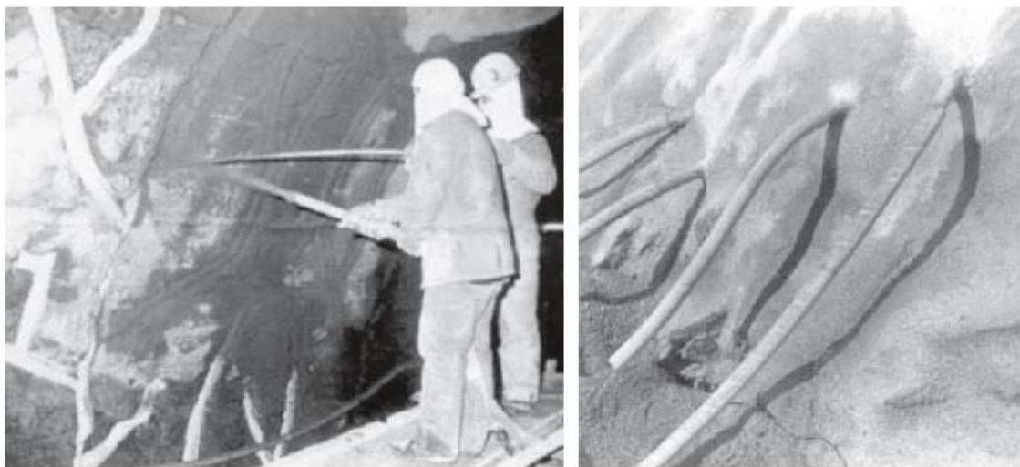
Slika 2-29 Drenažne cijevi (Kolymbas, 2008.)
