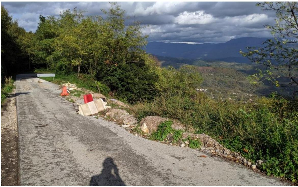
**Slika 2.3.** Fotografija oštećenja kolničke konstrukcije prometnice nastalog uslijed klizanja te krune klizišta, promatrane od JZ prema SI (fotografirano 4.11.2019).
