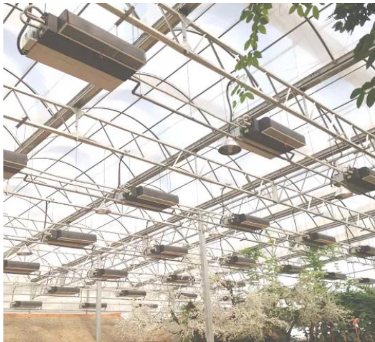
Slika 6-3. Stropni ventilokonvektor (Jindun Equipment, 2020)
