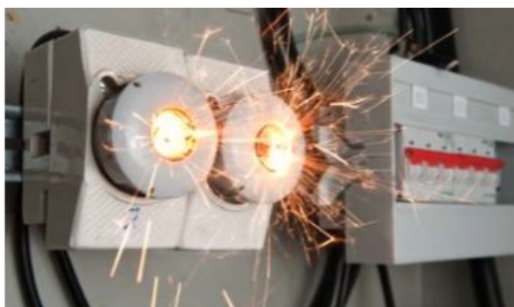
Slika 2-2 Eksplozija električnih ili magnetskih instalacija (MINERS priručnik, 2019.)
