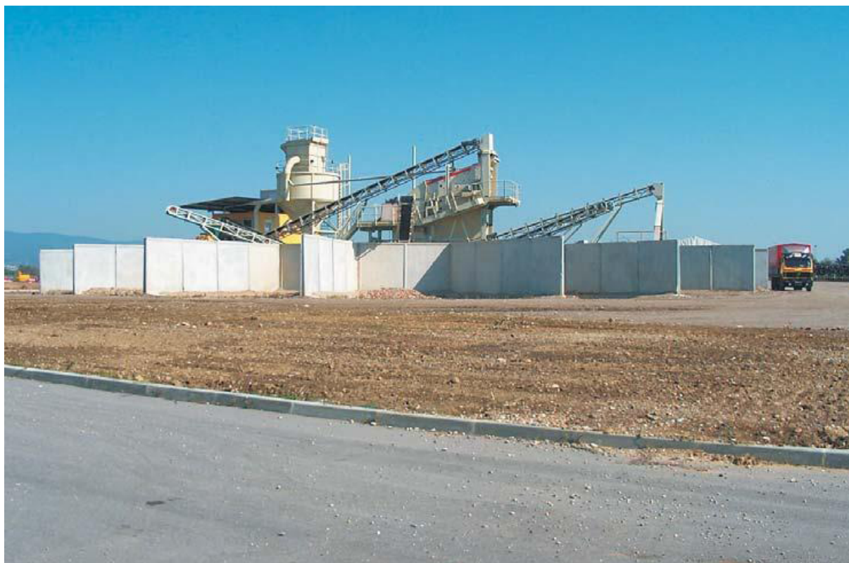
Slika 3.47: Postrojenje za reciklažu građevinskog otpada
