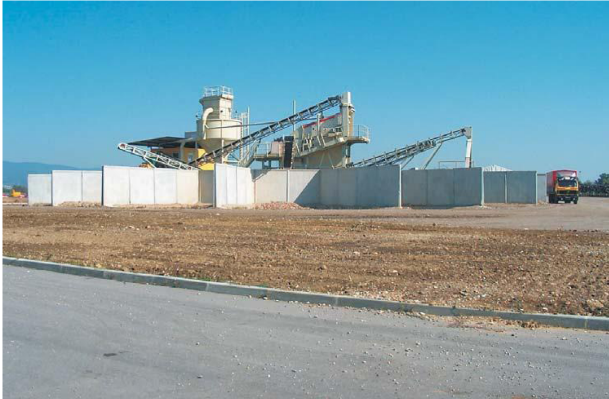
Slika 3.47: Postrojenje za reciklažu građevinskog otpada
