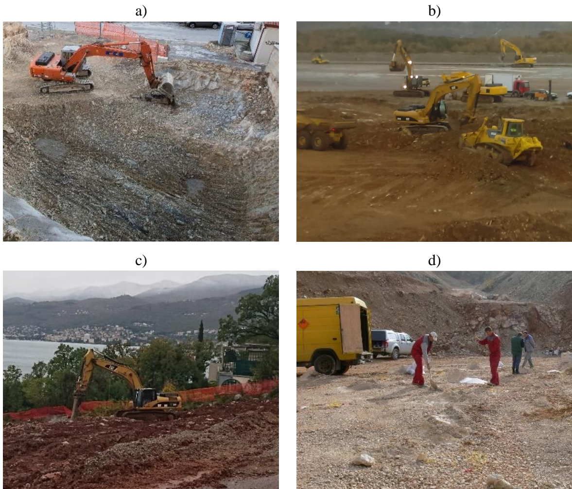
Slika 5.15. Probna otkopavanja: a) kopanje u Splitu; b) risanje u Vrbovskom; c) razbijanje u Segetu Donjem; d) priprema minskog polja u Kladnicama (Jug i sur., 2020)
