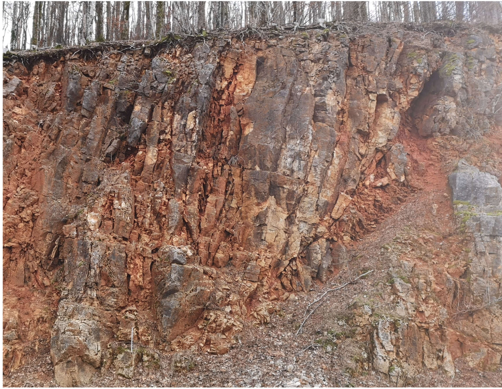
Slika 5-13 Inženjerskogeološka zona Z-6 - pogled na zonu.
