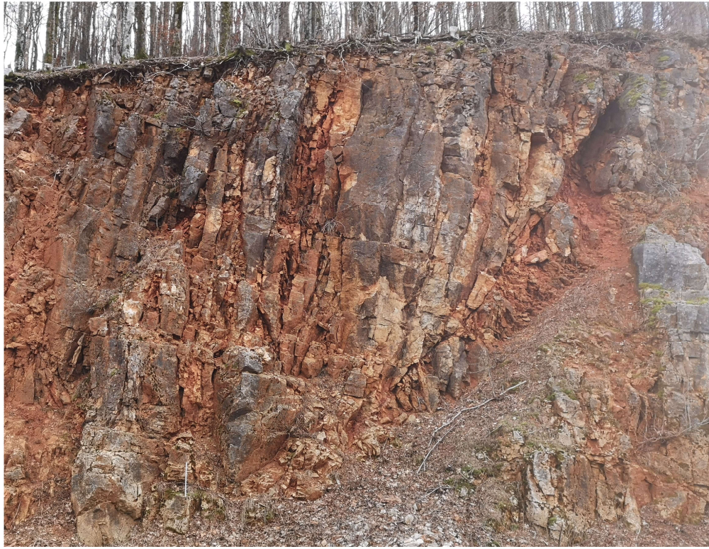
Slika 5-13 Inženjerskogeološka zona Z-6 - pogled na zonu.
