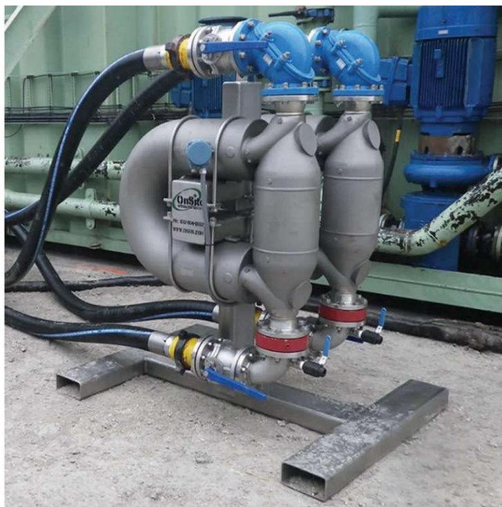
Slika 2-15. Coriolisov mjerač protoka (Jacobs, 2015)
