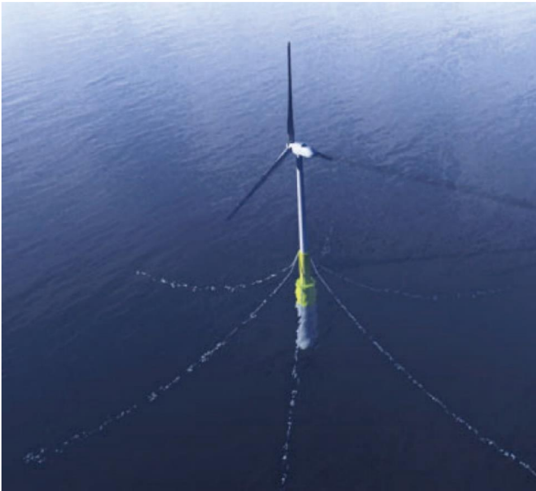
Slika 4-9. Spar turbina (Utsunomiya et al., 2010.)
