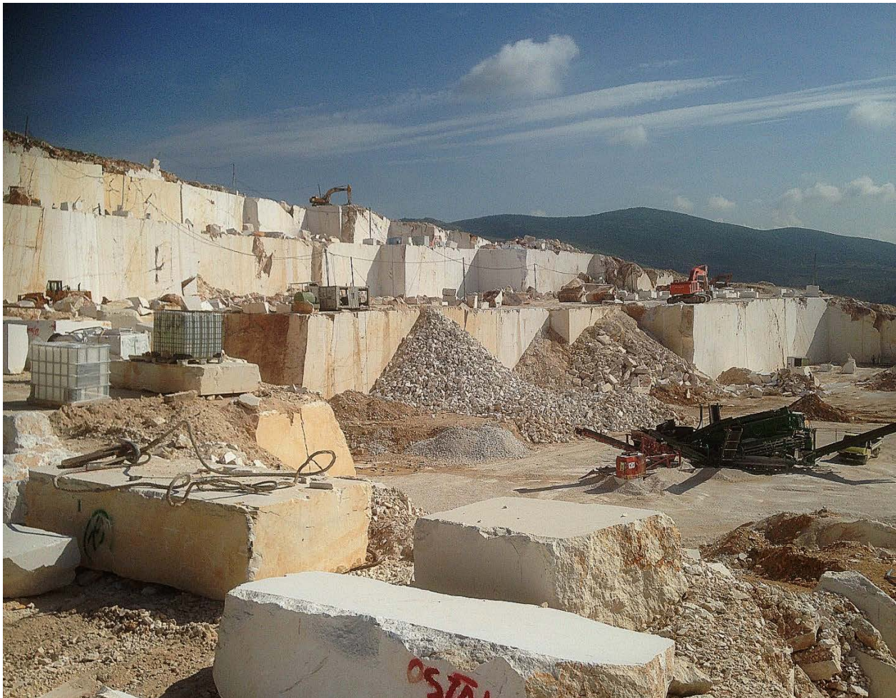
Slika 3.51. Eksploatacijsko polje arhitektonsko-građevnog kamena Redi
