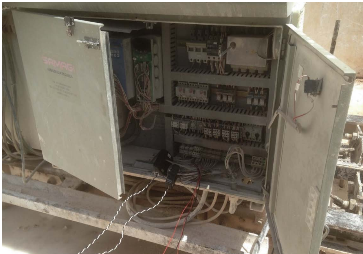
Slika 3.56. Posredno spajanje osjetila MT540 na glavni pogonski elektromotor lančane sjekačice
