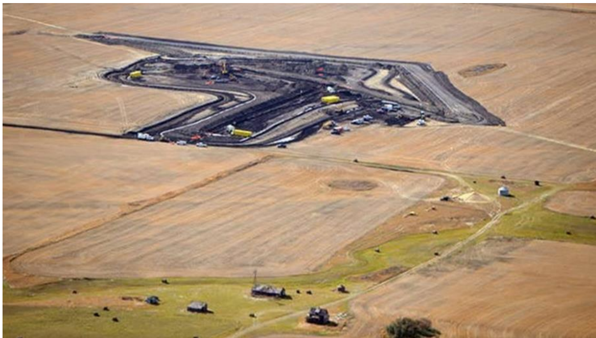
Slika 3-3. Izljev ugljikovodika iz podzemnog cjevovoda na poljima pšenice u Sjevernoj Dakoti (Global Research 2013)
