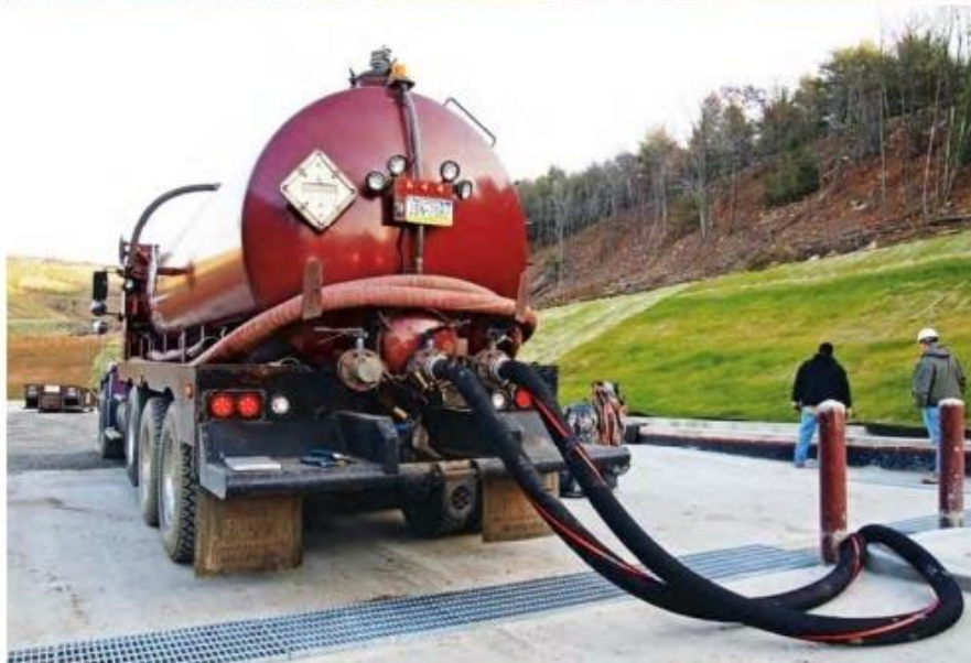
5-6. Dovod vode na obradu (Dahm i Chapman, 2014)
