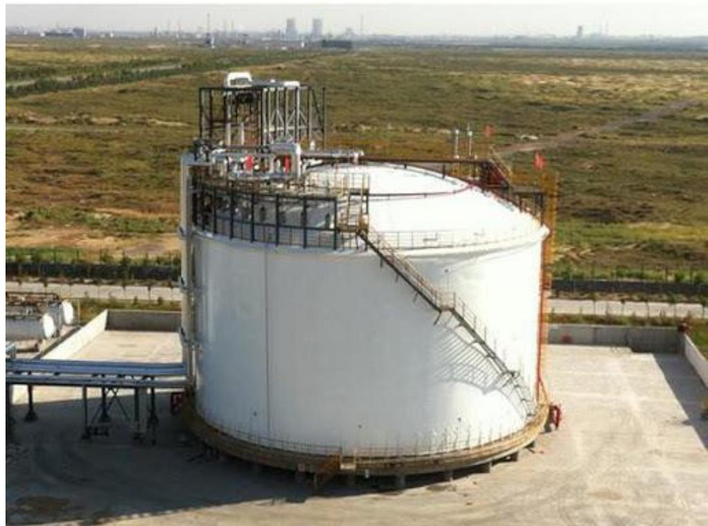
**Slika 3-4.** Nadzemni spremnik ukapljenog prirodnog plina s jednostrukom zaštitom
