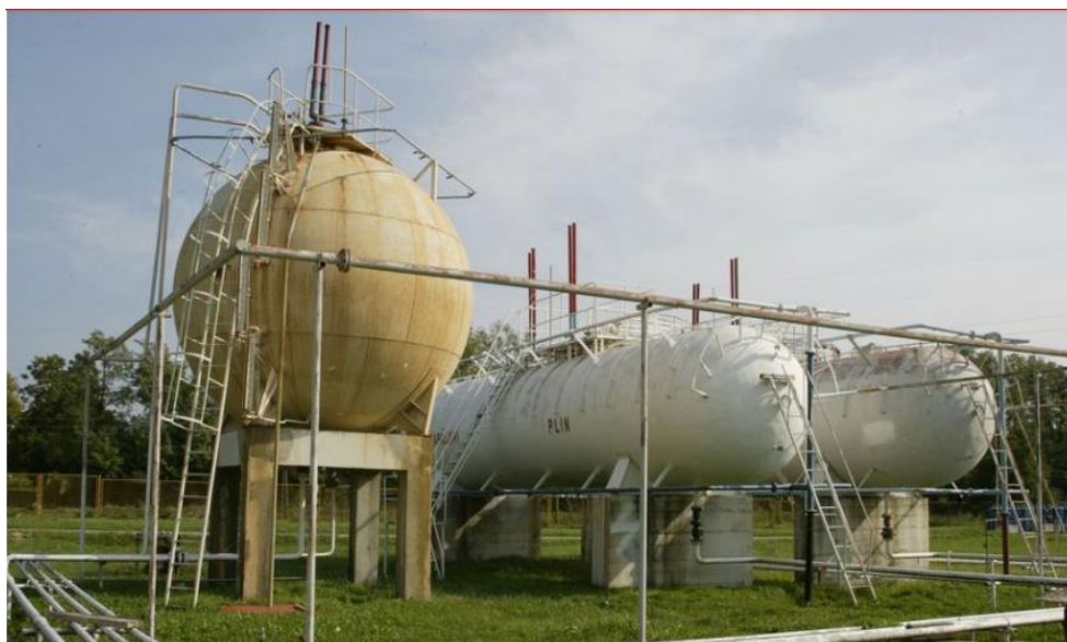
Slika 3-12. Različite izvedbe spremnika ukapljenog naftnog plina
