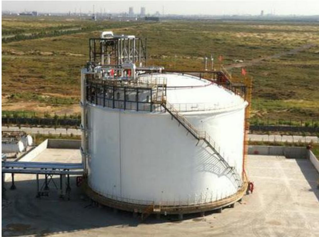
Slika 3-4. Nadzemni spremnik ukapljenog prirodnog plina s jednostrukom zaštitom ( http://www.guangriben.com/chanpin/167.html )
