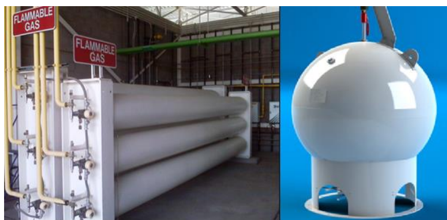
Slika 3-9. Cilindrični i sferični spremnik stlačenog prirodnog plina
