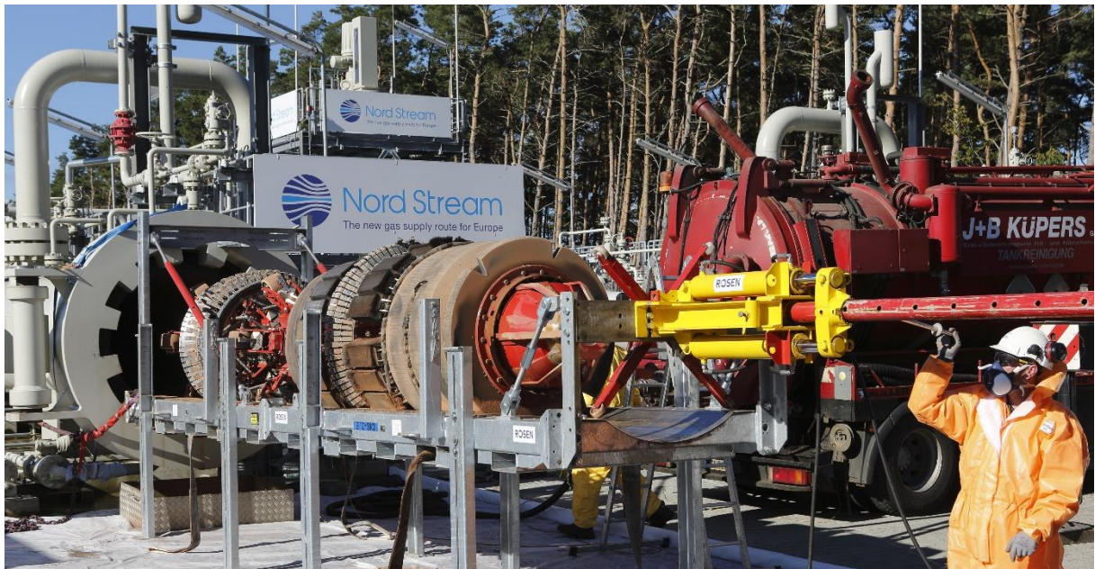
Slika 5-2. Pregled plinovoda pomoću „pametnih pigova“ (Gazprom (a))
