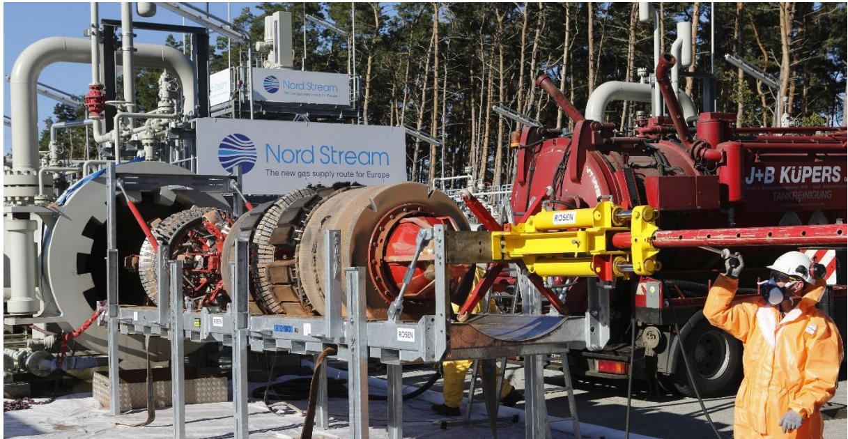
Slika 5-2. Pregled plinovoda pomoću „pametnih pigova“ (Gazprom (a))
