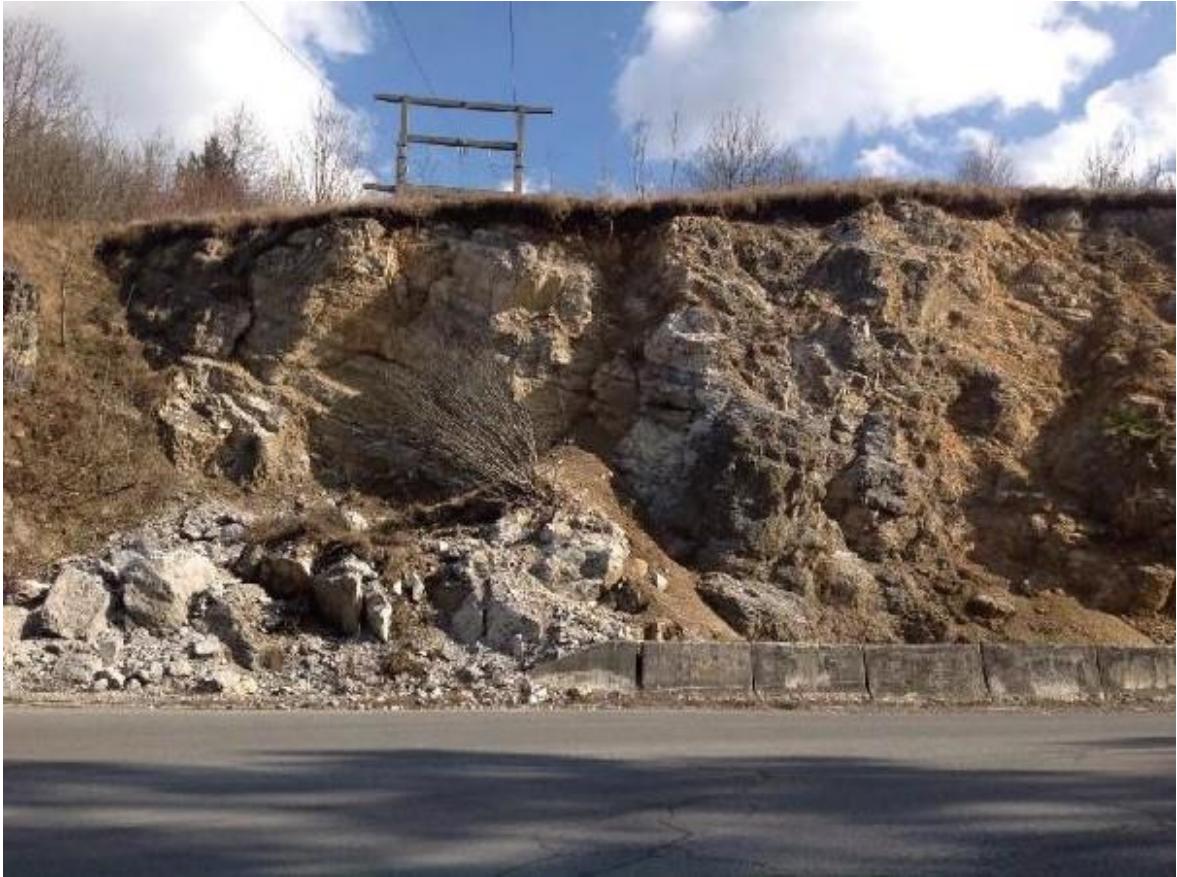
Slika 3-5. Izdanak gornjotrijaskih dolomita na zavoju ceste koja iz centra Vrbovskog vodi preko rijeke Dobre do željezničke postaje Vrbovsko. Slojevitost u dolomitu obilježava izmjena tamno i svjetlosivih stromatolitnih lamina i slojeva. Točka istraživanja T7, koordinate X=5505859 Y=5026356 , Tablica I.
